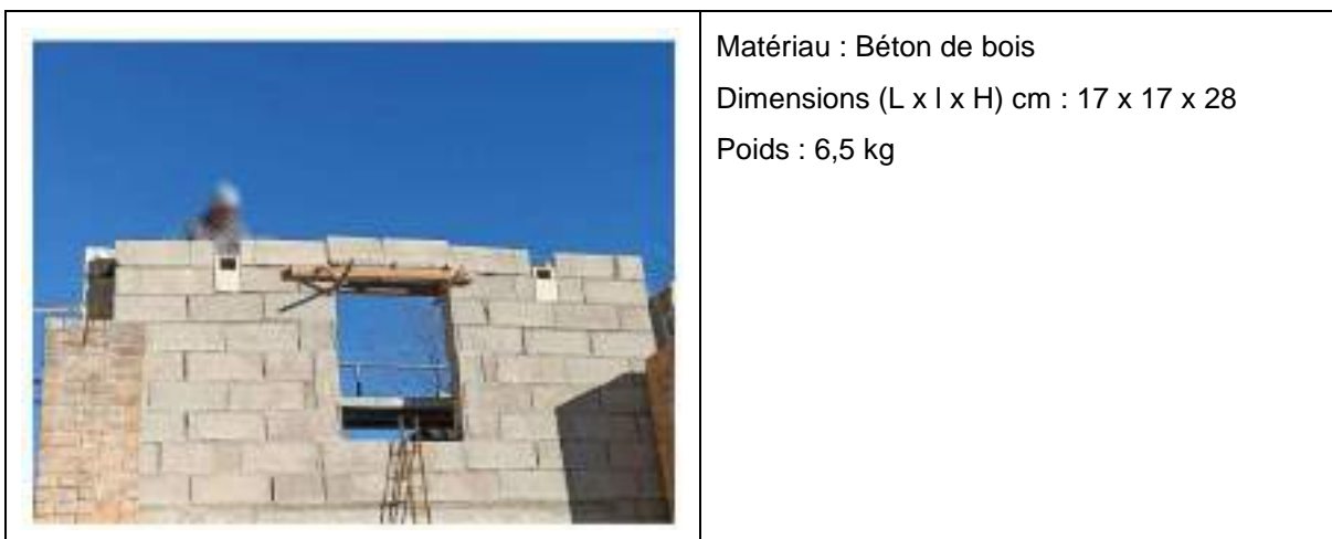
Figure 174 : Exemple de nichoir à Rougequeue noir intégrable en façade
