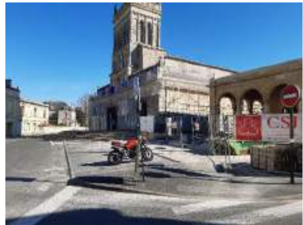
Vue de l'église Saint-Pierre
