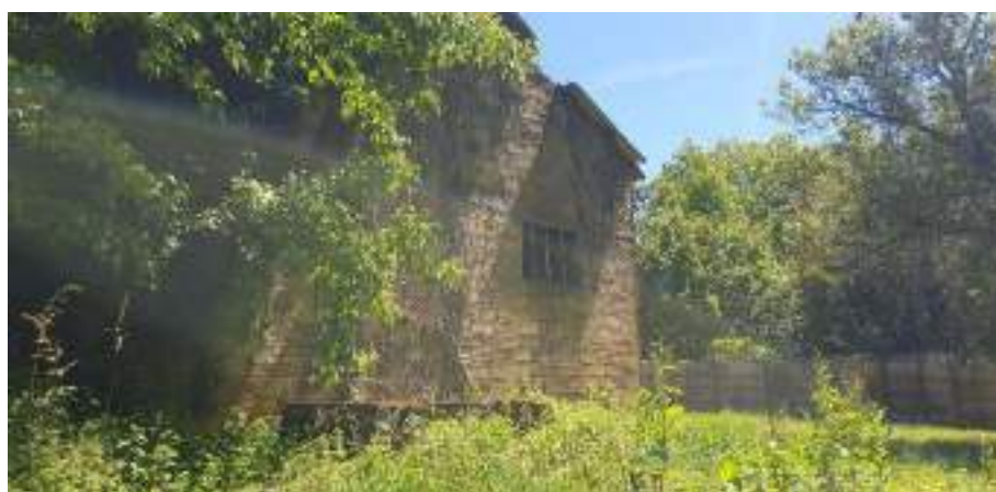
Bâtiment favorable aux chiroptères – photo : Y. BERNARD/ELIOMYS
